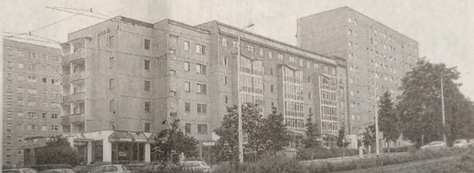
Vor der Sanierung: pure Tristesse. In dem Plattenbau an der Bahnhofstraße gab es trotz günstiger Lage viel Leerstand.
